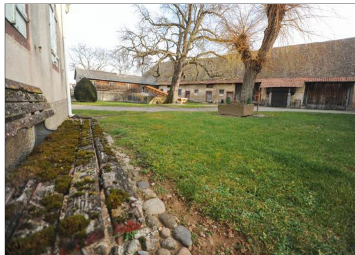
Vue sur la grange, longue de 40 mètres, et sur l'un des hangars agricoles.
