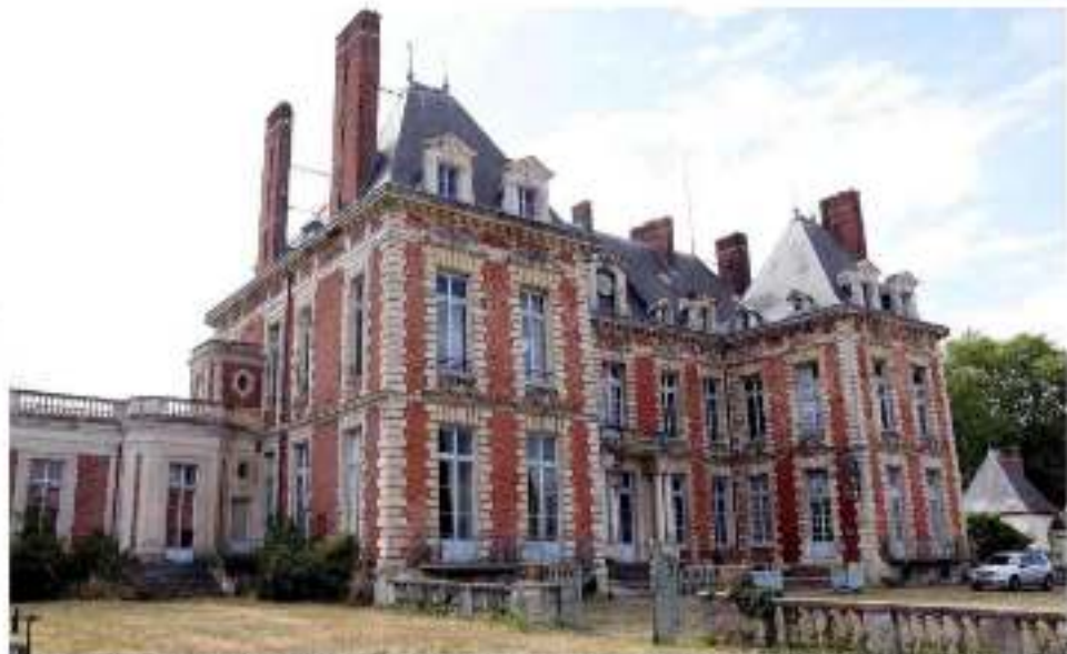
Yerres (Essonne), le 24 juillet. L'édifice étant un monument historique, la restauration devra être validée par les Bâtiments de France.
