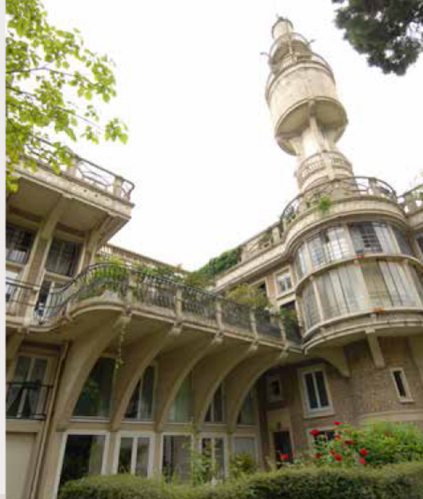
François Hennebique a pris une grande liberté de formes conférant à l'ensemble un aspect exubérant. Ici, la tour de 40 m.
