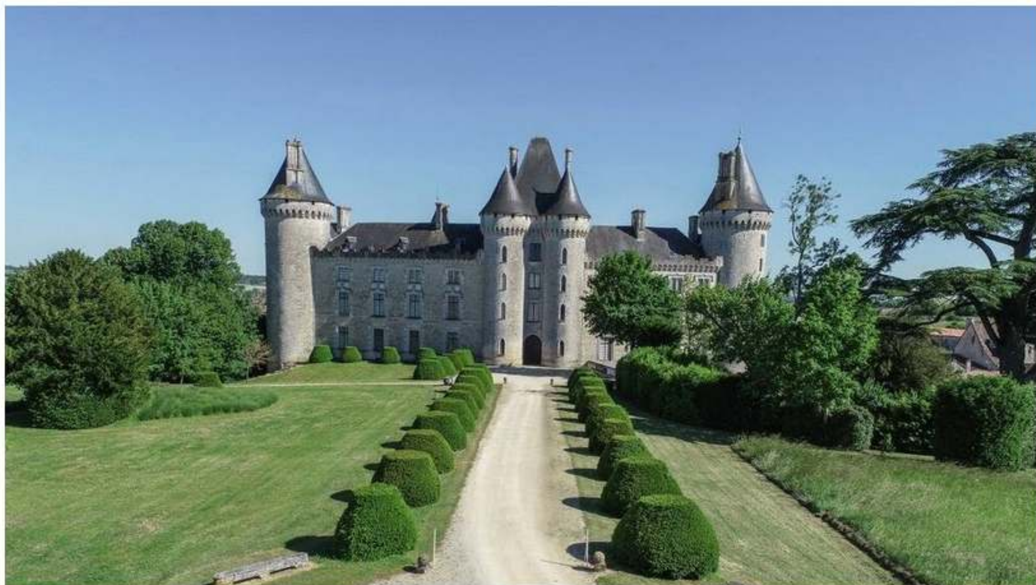
Vue de l'extérieur du château de Verteuil © Patrice Besse
