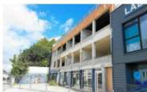
Enseigne Château d'Aix qui avait investi à la fin le bâtiment a été rénové.
