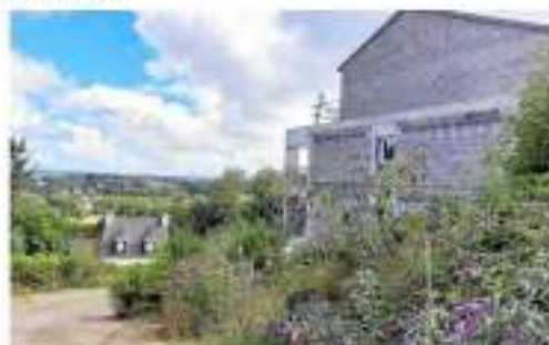
Plusieurs constructions sont déjà en cours sur la vieille route de Rosperden, avec une perspective sur la campagne. (Source: l'Urbanisme / Bâtisse Direct)
