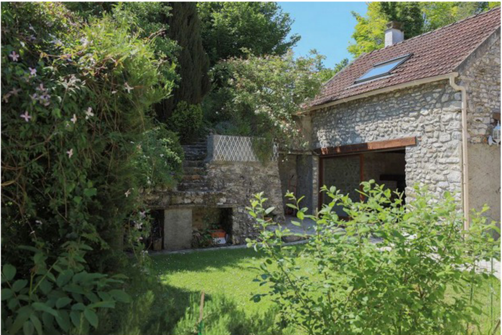
Le logis indépendant dispose d'un rez-de-chaussée assez lumineux grâce à une baie vitrée. (Agence Patrice Besse)
